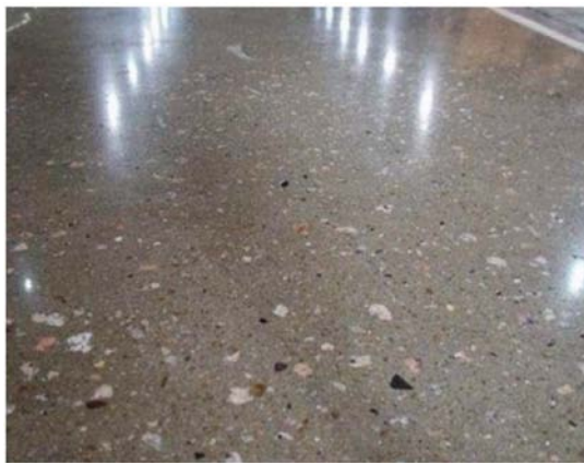
图 6 金刚砂耐磨防静电地坪
