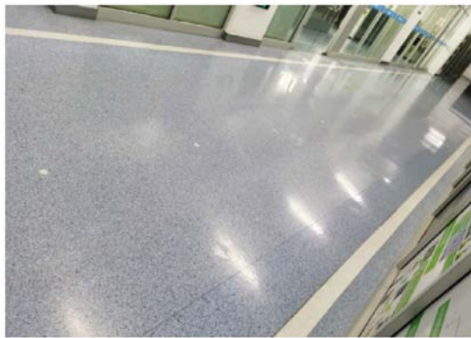
图 4 PVC 现场防静电地坪使用图
