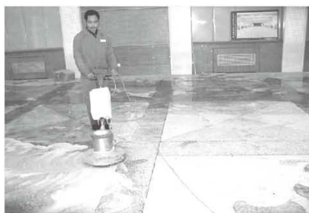
图6 水磨石施工图
